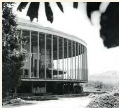
1972: Zwei Jahre vor der Eröffnung nahm die architektonische Gestalt des Brucknerhauses Linz bereits Form an.
